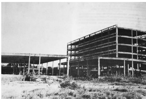
Obras do Hospital
